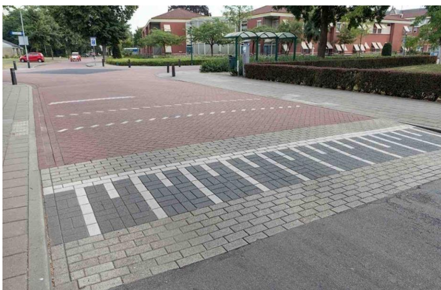
Рисунок 15. Пример приподнятого пересечения
